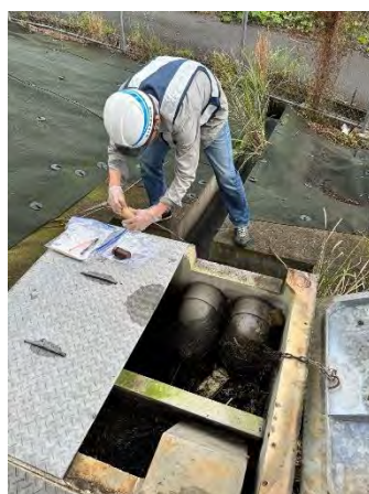
図2. 集水枡での調査
